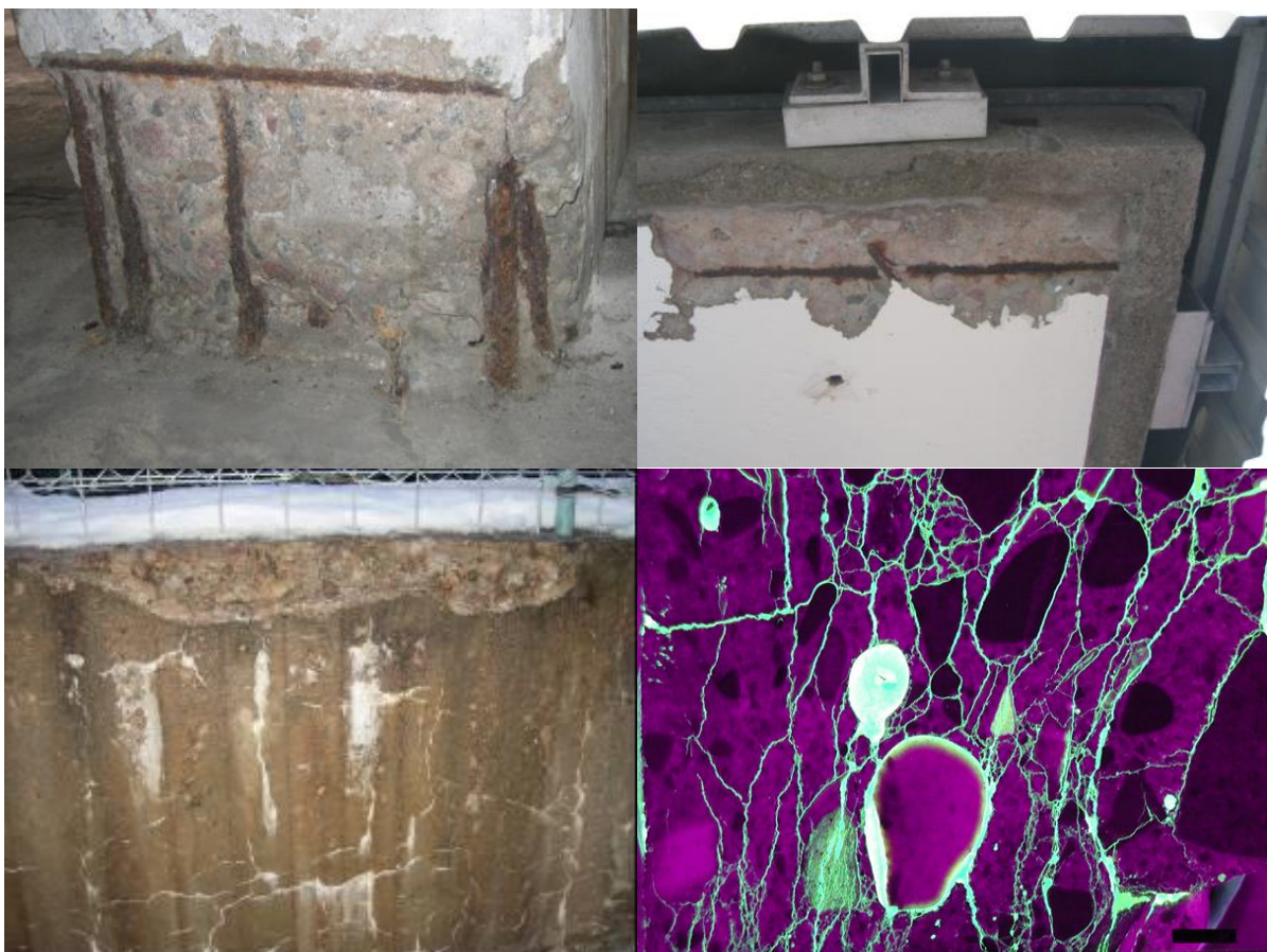
Figur 1: Ö: tv: Kloridinitierad armeringskorrosion på pelarfot i parkeringsgarage, Ö:th: Karbonatiseringsinitierad armeringskorrosion på underkant balkong, N:tv: Frostskadad stödmur, N:th: Tunnslipsanalys på ett ASR angrepp.
